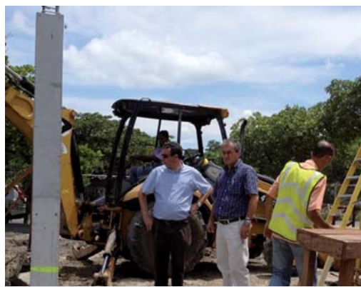
Los técnicos españoles de Heliopol a cargo de las obras.
